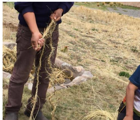
Figura 15: se habilita las cuerdas torcidas desacuero a los requerimientos, de barandas balaustres, y piso del puente.
